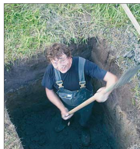
Bild 3: Der Aufwand für eine hinreichend große Fundamentgrube ist nicht zu unterschätzen ...
