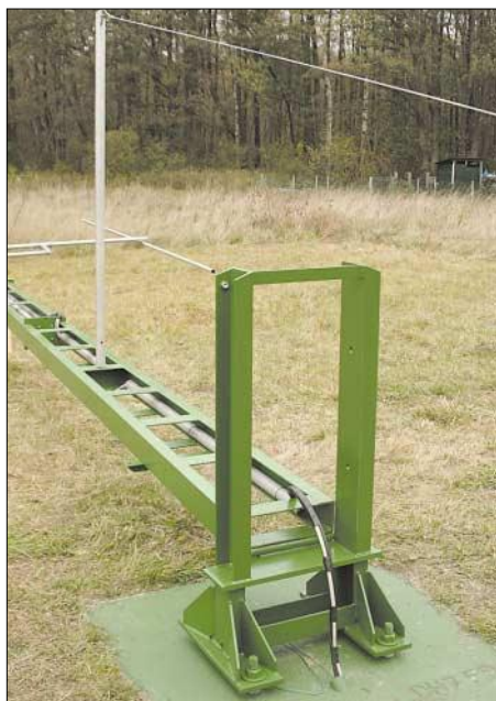
Bild 5: Umgebauter Bahnstrommast nach dem Fahnenmastprinzip; gut zu erkennen die Vorrichtung zum Aufrichten: ein Hilfsmast als „toter Mann“ und 5 mm dicke Drahtseile zur Spitze des Mastes und zu einer 5 m entfernten Winde. Auch deren Fundament muss sehr standfest ausgeführt sein!
